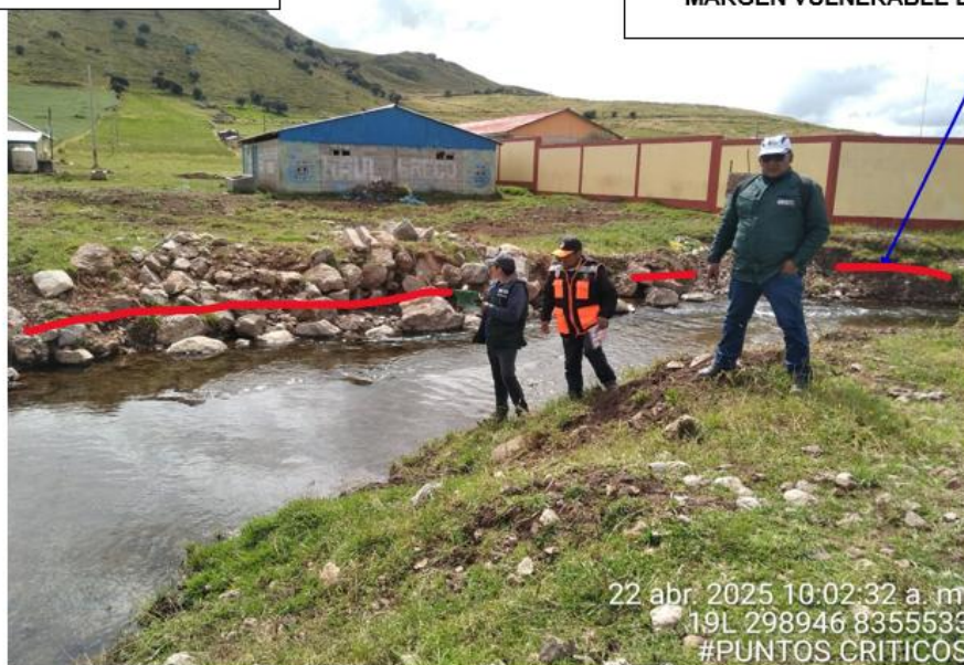
FIGURA N°02: ZONAS PROPENSAS ANTE UNA CRECIDA DEL RÍO PUMARIMAYO Y LA EROSION EN LA MARGEN IZQUIERDA, PERDIDAS DE SUELOS AGRICOLAS Y PELIGRO DE DESBORDE CON DAÑOS A INFRAESTRUCTURA DE CENTRO EDUCATIVO
